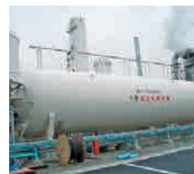
(株)ハイドロエッジ 液化水素タンク他据付
