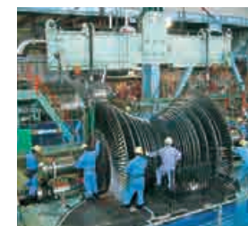
関西電力(株)美浜発電所 蒸気タービンの分解工事
