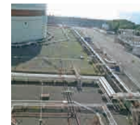
タンク洗浄工事仮設パイプライン
