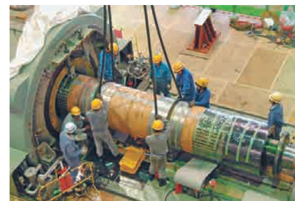
関西電力(株)相生発電所 電気関係定期点検工事 発電機ロータ引抜作業
