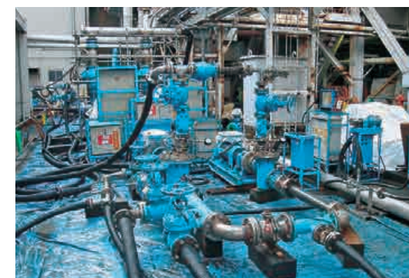
ボイラ洗浄工事仮設パイプライン
