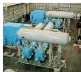
堺LNG(株) BOG(ボイル・オフ・ガス)圧縮機据付
