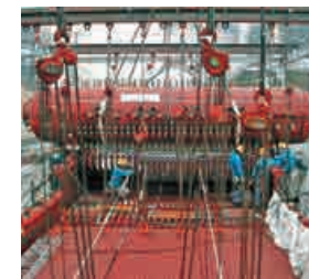
兵庫バルブ工業(株)谷川工場 自家用発電設備汽水ドラム据付
