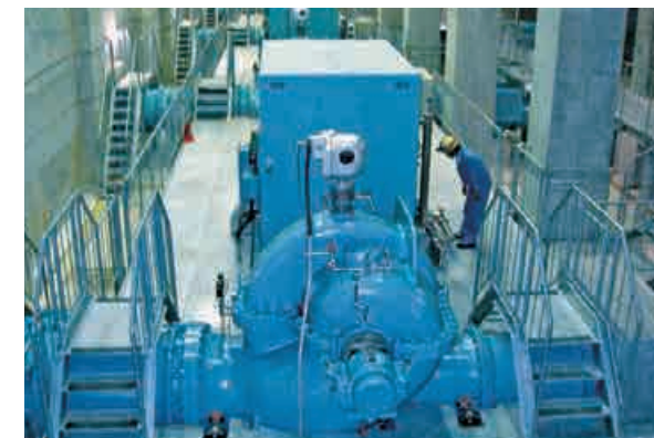
浄水場配水ポンプ設備据付工事
