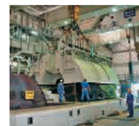
関西電力(株)南港発電所 タービン定期点検工事 タービン分解作業
