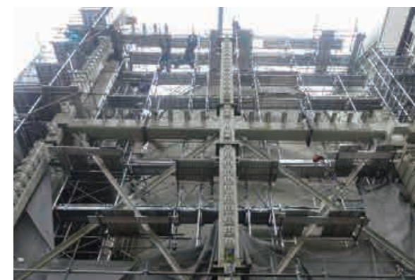
復水タンク竜巻飛来物対策設備設置工事
