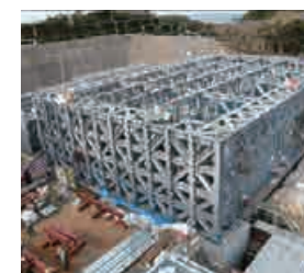
海水ポンプ竜巻飛来物対策設備設置工事
