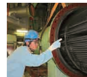
1次系熱交換器耐震裕度向上工事
