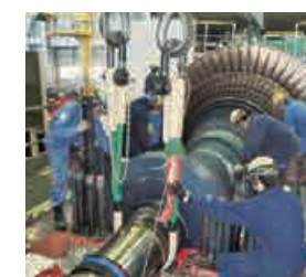
関西電力(株)姫路第二発電所 タービン定期点検工事 タービン分解作業
